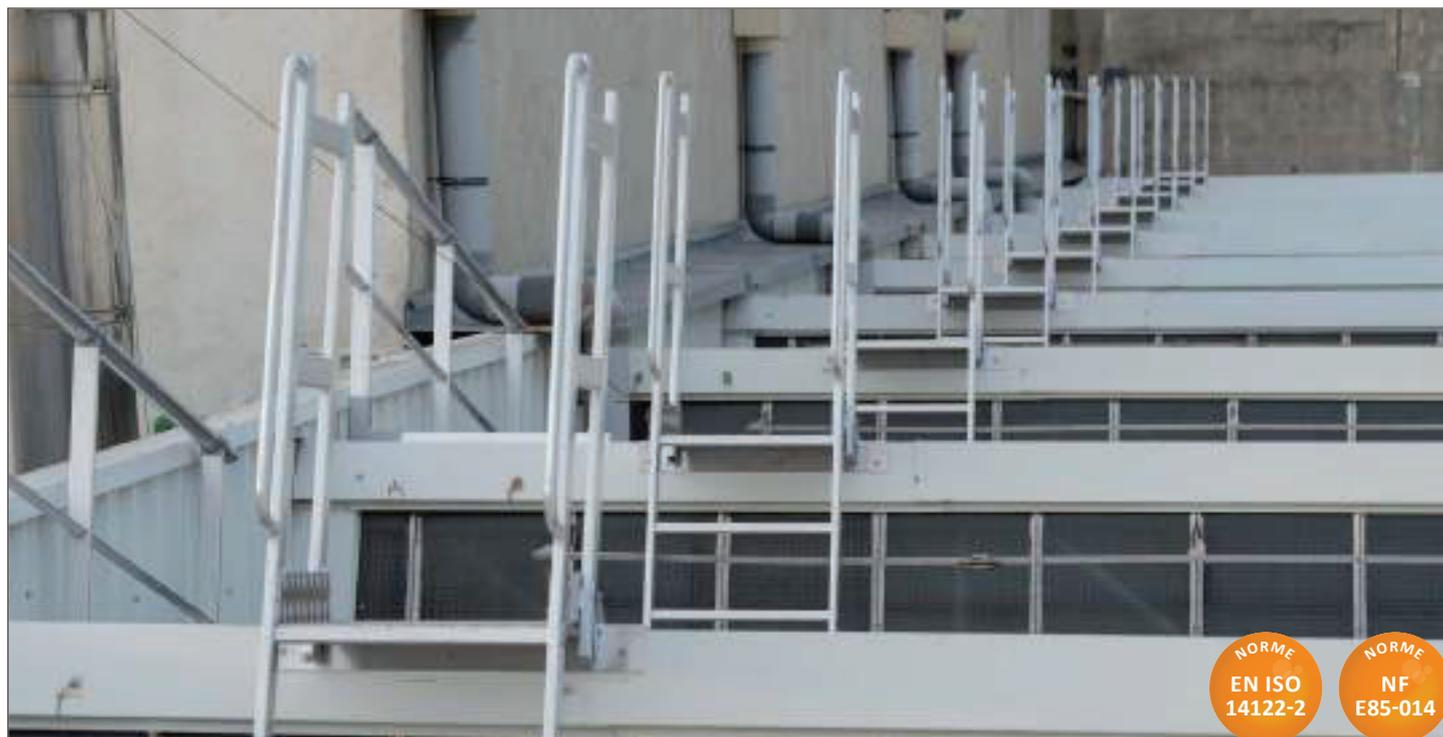
**LA PASSAGE DE SHED VECTAWAY®** permet de passer en toute sécurité au-dessus d'acrotères, de gaines, d'édicules et de joints de dilatation. Cet équipement permet de franchir «un shed» ou une toiture à redents, en toute sécurité et de circuler sur des toitures présentant un profil en dent de scie, composée d'un versant de pente rapide et d'un autre de pente plus faible. Ce dispositif s'adapte à tout type de support (système en kit autoportant ou fixation sur structure).
