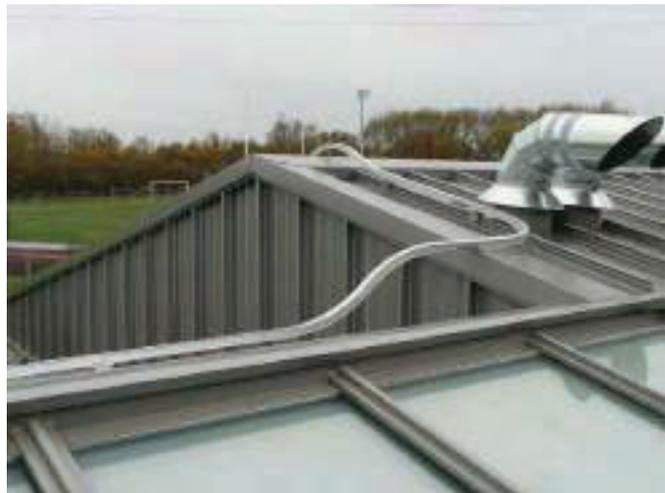
CE TYPE DE LIGNE DE VIE SUR RAIL se compose d'un rail de guidage et d'un chariot coulissant. Le rail peut être situé sur un support soit au sol, soit à côté ou soit au-dessus de l'opérateur. Il existe différents types de chariots suivant la position du rail.
