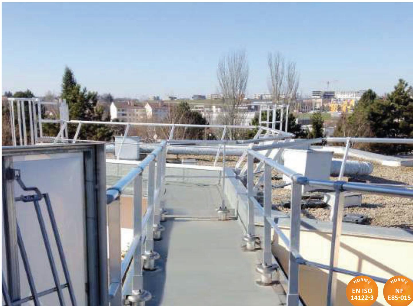
**LE GARDE-CORPS VDE/VDS VECTACO®** se fixe sur dalle isolée à travers le complexe d'étanchéité par le biais de son embase sabot D ou DS. Ces embases sont réalisées sur mesure et sont conformes au DTU 43.1, normes d'étanchéité des toitures terrasses.
