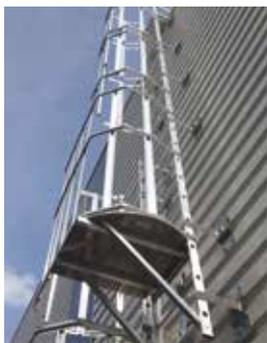
L'échelle à crinoline VECTALADDER® est un dispositif permettant l'accès en hauteur à des zones réservées au personnel autorisé tels que les bâtiments industriels, les installations industrielles ou encore les terrasses techniques.
